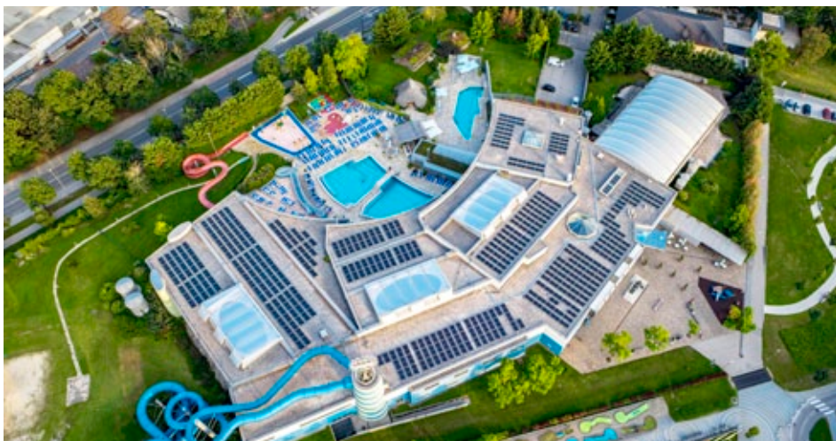
Sončna elektrarna v BTC City Ljubljana na strehi Vodnega mesta Atlantis
