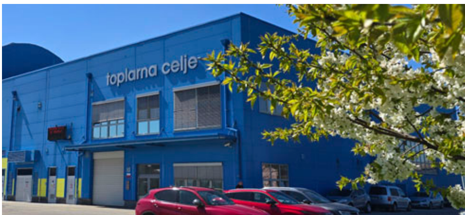
V Toplarni Celje vsako leto iz odpadkov proizvedejo približno 9.000 MWh električne energije in več kot 40.000 MWh toplote za sistem daljinskega ogrevanja.
