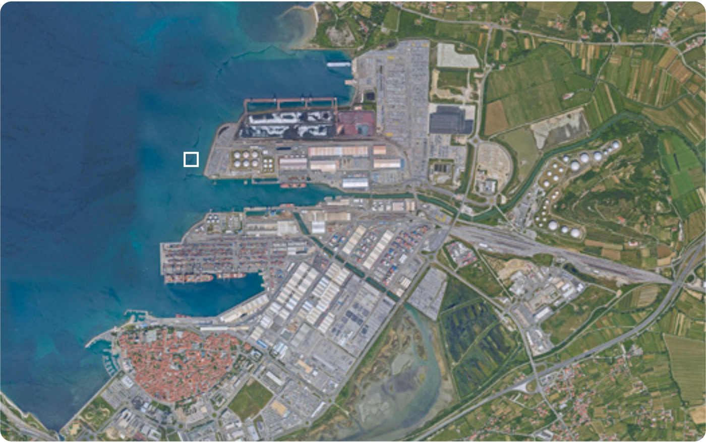
Lokacija postavljene stacionarne merilne postaje za podvodni hrup na območju pristanišča
