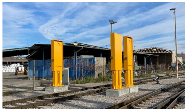
Slika nekaterih portalov za spremljanje radioaktivnosti pošiljk v pristanišču
