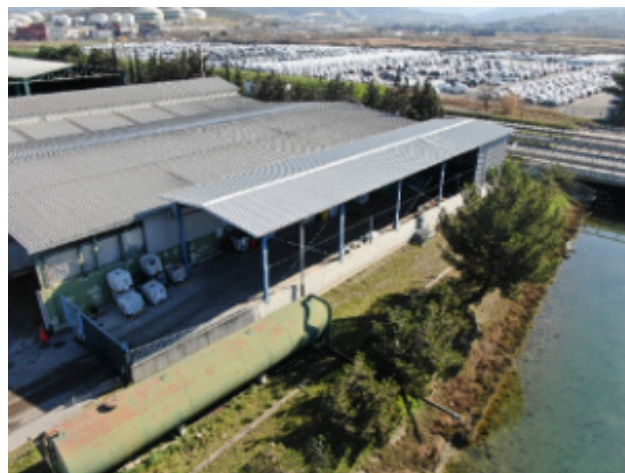
Center za ravnanje z odpadki - območje za skladiščenje nevarnih odpadkov
