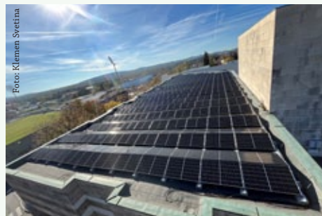
Vzpostavljane sončne elektrarne na strehi Kosovelovega doma Sežana
