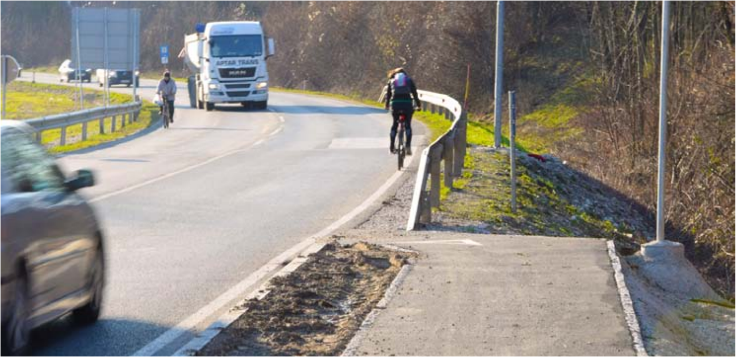
Prevozno revščino povzroča tudi neobstoječa kolesarska infrastruktura, kar prizadene zlasti ljudi brez avtomobila. Foto: Simon Koblar
