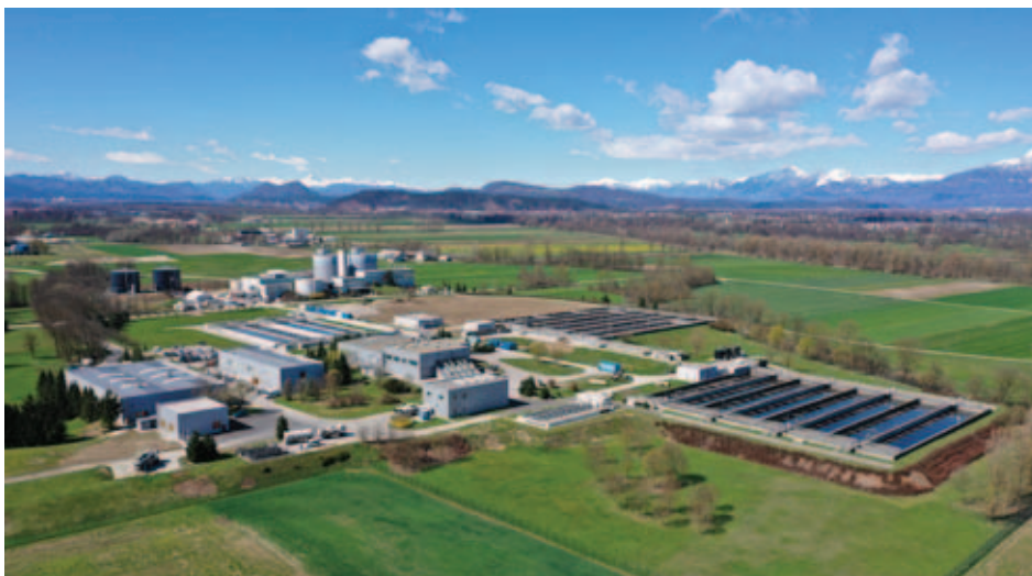
Vzporedno z nadgradnjo Centralne čistilne naprave Ljubljana so pred iztokom v Ljubljano namestili ustrezne priključke, ki bodo v prihodnje služili za črpanje prečiščene odpadne vode za potrebe čiščenja bazenov in pohodnih površin na lokaciji.
