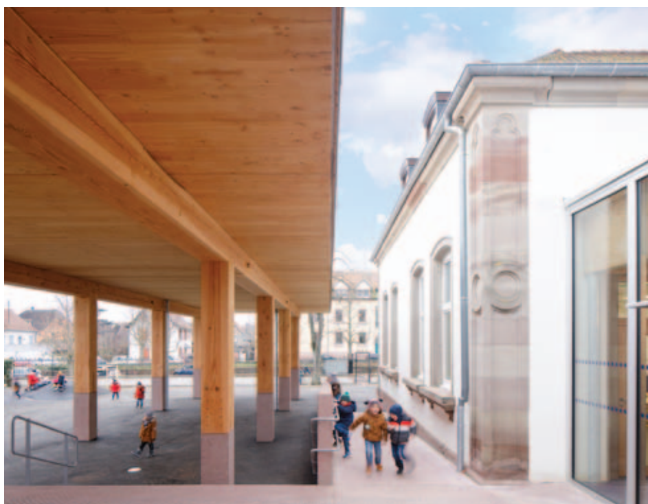
Predprostor vrtca La Jette. Novi predprostor vrtca La Jette med stavbo in dvoriščem je iz lesenih masivnih stebrov iz lesa iz okoliških gozdov. Les se ob uporabi tiho suši, kar povzroča zaželeno napako, grče in razpoke, ki izražajo posebnost vsakega elementa, tako v poetičnem kot tudi v didaktičnem pogledu. Foto: C. Guillaume
