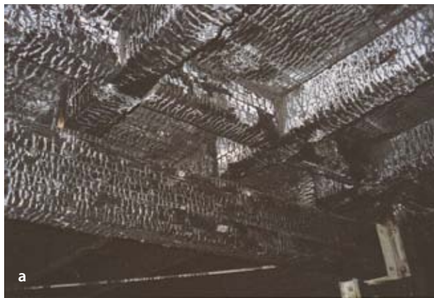
Slika 1: Požar v termalnem bazenu Zreče aprila 2001 – stanje pred sanacijo (a) in po sanaciji (b)
