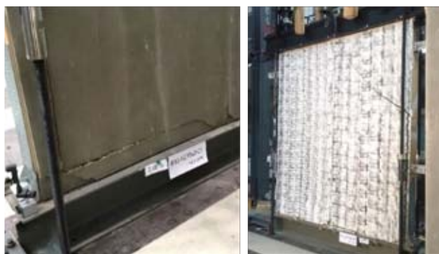
Slika 5: Tipični porušni mehanizem nadgrajenih panelov
