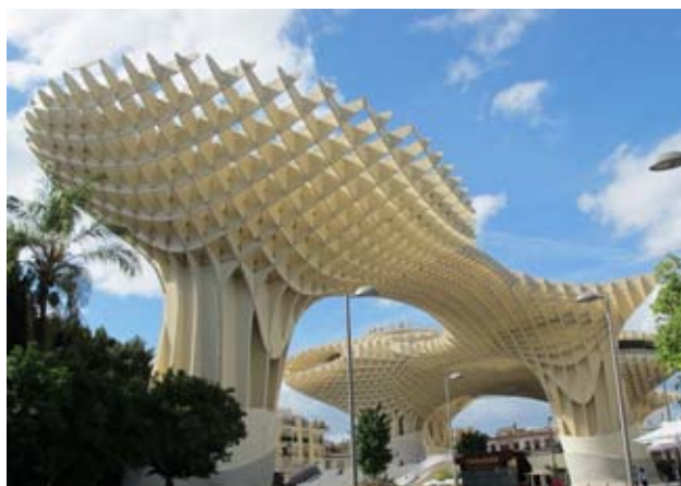
Slika 7: V Sevilli ob tržnici stoji Metropol Parasol, znan tudi kot "sevilska goba". To je ena od največjih lesenih konstrukcij na svetu (150 x 70 metrov in 26 metrov višine). Zgrajena je iz naprednih lesenih kompozitov. Foto: Anton Kambič
