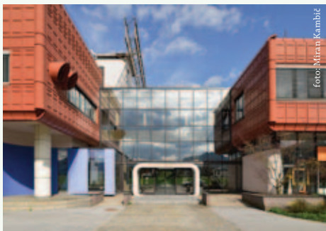
Obnova industrijsko-trgovskega objekta iz 70-ih let prejšnjega stoletja v Kranju (Center Gorenjska). Leto izvedbe: 2010/Investitor, izvajalec: CG, d.o.o.
