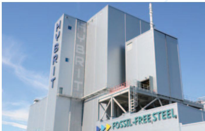
HYBRIT, pilotni projekt zamenjave tehnologije plavžev na osnovi premoga z neposredno redukcijo, ki temelji na nefosilnem vodiku (foto: Åsa Bäcklin)
