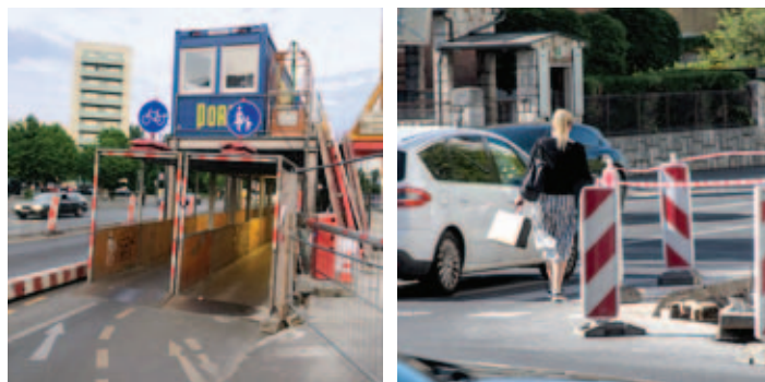
Slika 5: Nadomestna varna pot za kolesarje in pešce v času gradbenih del v Berlinu (levo). Gradbišče brez nadomestnih varnih poti za kolesarje in pešce v Ljubljani (desno). Avtorja fotografij: Koblar, 2022 (levo) in Kumer, 2022 (desno).
