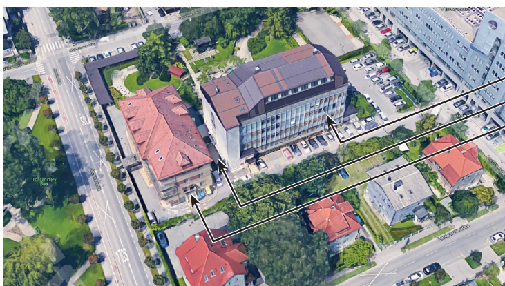
Slika 1: Obravnavana stavba – Center IRIS
