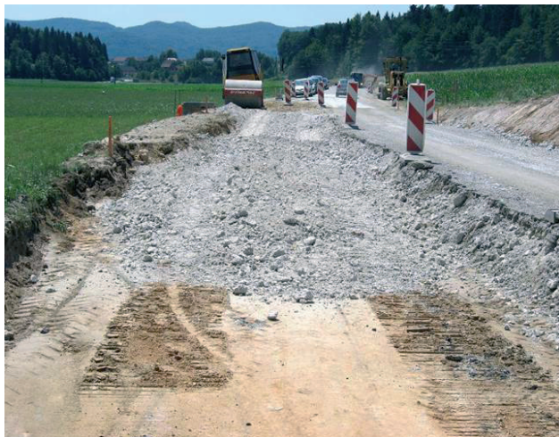
Slika 3: Vgradnja recikliranega agregata iz betona v nosilno nevezano plast ceste
