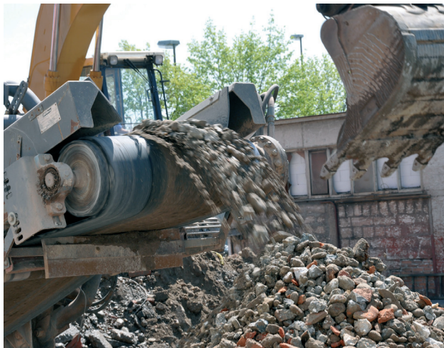
Slika 1: Predelava mešanih gradbenih ruševin in hkrati tudi proizvodnja recikliranega agregata
