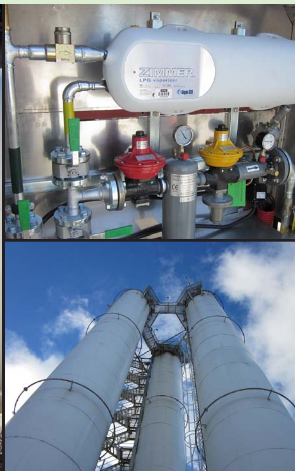
Plinohram za UNP na plinski postaji Ilirska Bistrica (na fotografiji levo), električni uparjalnik UNP na objektu Marche na Lomu (desno zgoraj), skladišče UNP v Štorah (desno spodaj).
