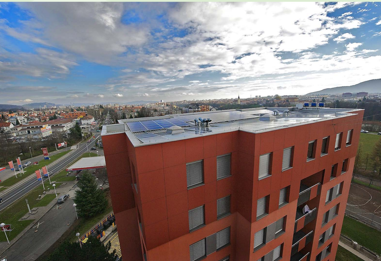
Fotovoltaične elektrarne so del celostnega projekta energetske učinkovitosti, ki ga izvajamo za Univerzo v Mariboru.
