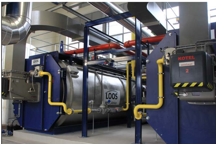
Z novimi vročevodnimi kotli v ravenski toplarni smo izboljšali učinkovitost pretvorbe zemeljskega plina za dobrih 14 %.
