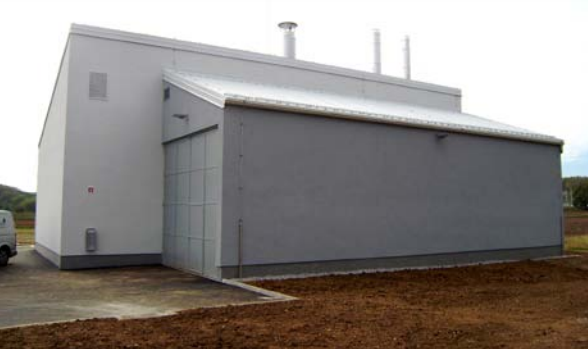
Kotlovnica v Metliki
