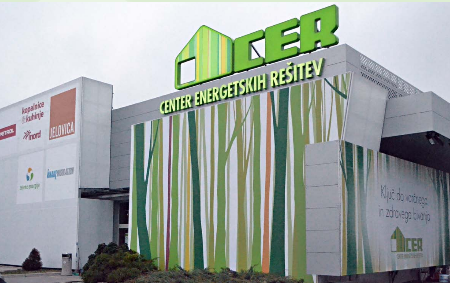
Center energetskih rešitev v BTC Cityju v Ljubljani
