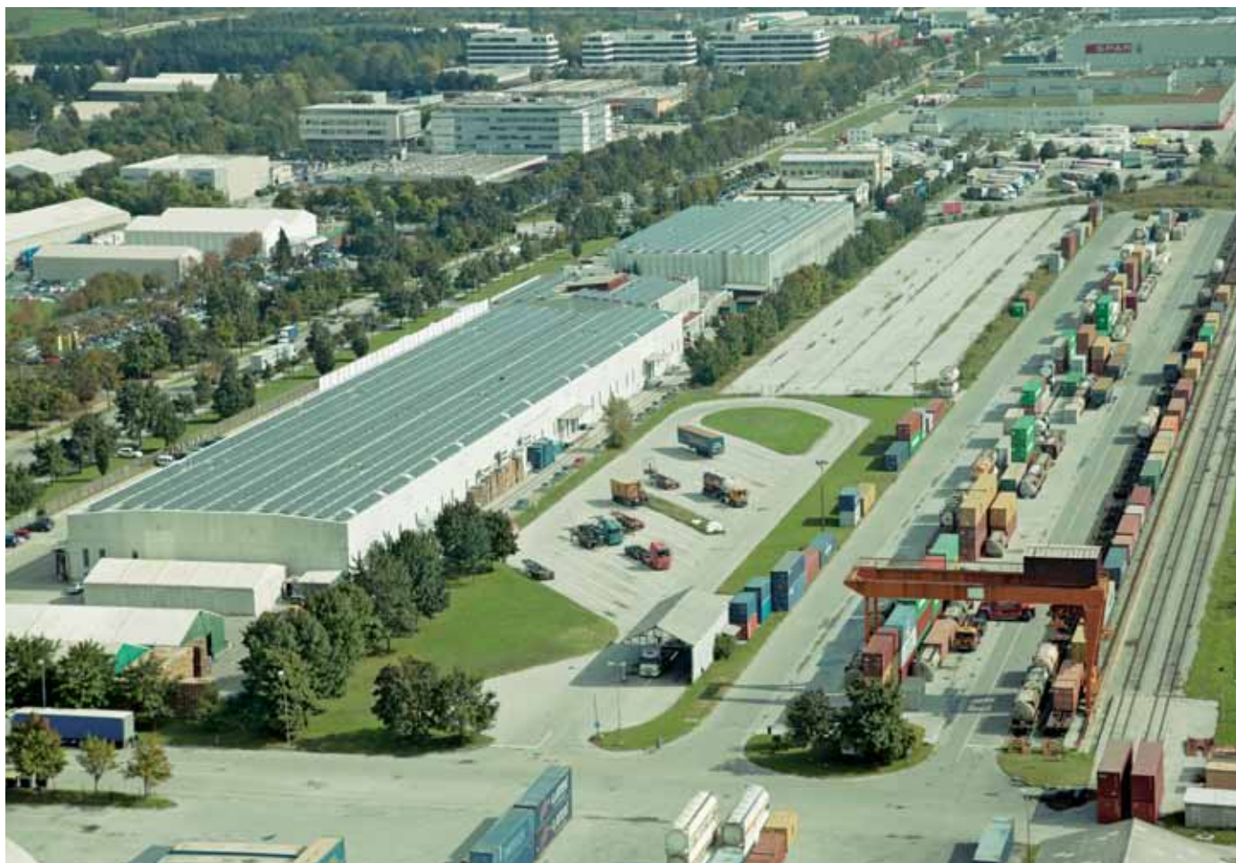
Sončna elektrarna v logističnem centru BTC v Ljubljani
