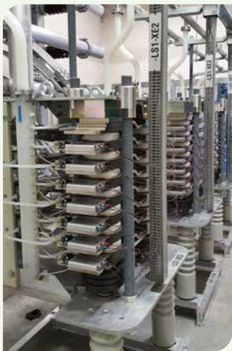
Nov stolp kompenzacijske naprave SVC v SIJ Acroni, foto: Darko Mandelc, SIJ Acroni
