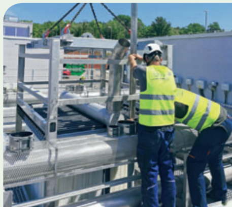
Vgradnja membranske kasete
