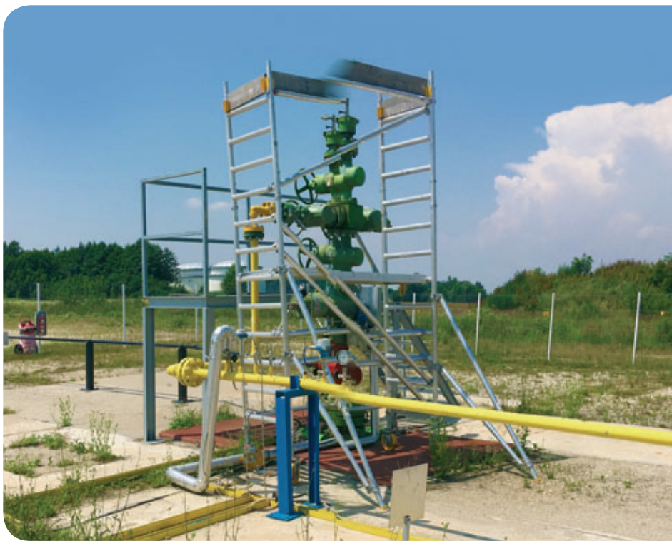
Delujoča proizvodna vrtina v Petišovcih za pridobivanje plina iz globokih geoloških plasti.
