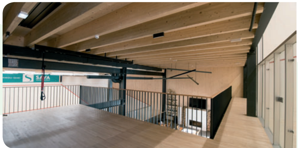
Zaključen športni objekt Squashland v Ljubljani notranjost konstrukcije foto Bian Dujč
