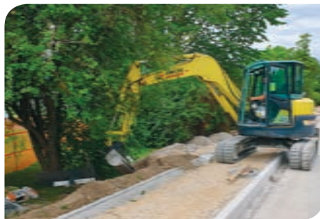
Gradnja kolesarske steze
