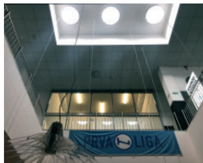
Z energijsko varčnim Solatube hibridnim LED sistemom širimo možnosti uporabe dnevne osvetlitve.
