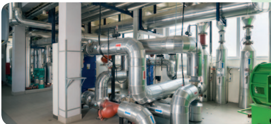
Toplotni izmenjevalniki sistema izkoriščanja odvečne toplote
