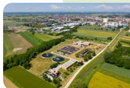
Komunalna čistilna naprava Murska Sobota
