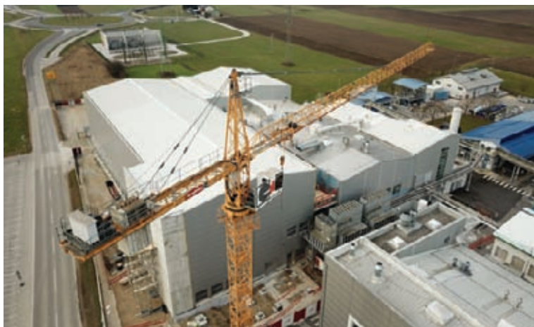
Gradnja novega objekta za proizvodnjo bioloških učinkovin (Biološke učinkovine Mengeš).
