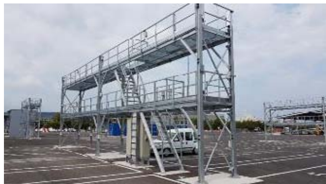
Galerija in priklop za frigo kontejnerje
