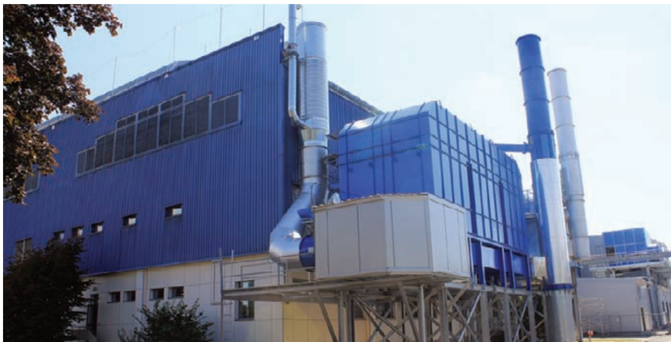
RTO naprava v Ljubljani za regeneracijsko termično oksidacijo emisij hlapnih organskih spojin.
