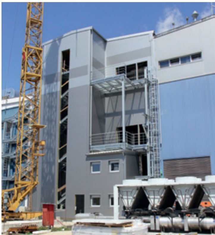
Izolacija vmesnega izdelka z zagotavljanjem striktno nadzorovanih pogojev REACH-SCC v Lendavi.
