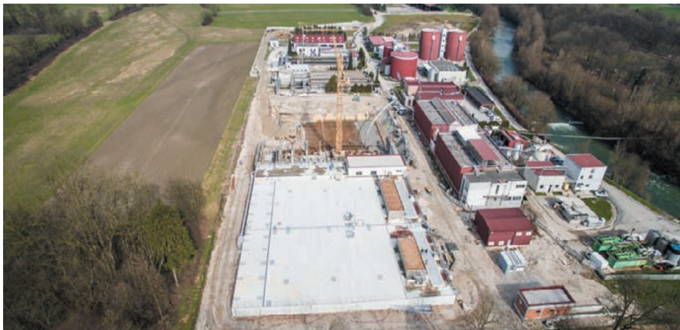
Centralna čistilna naprava Domžale-Kamnik
