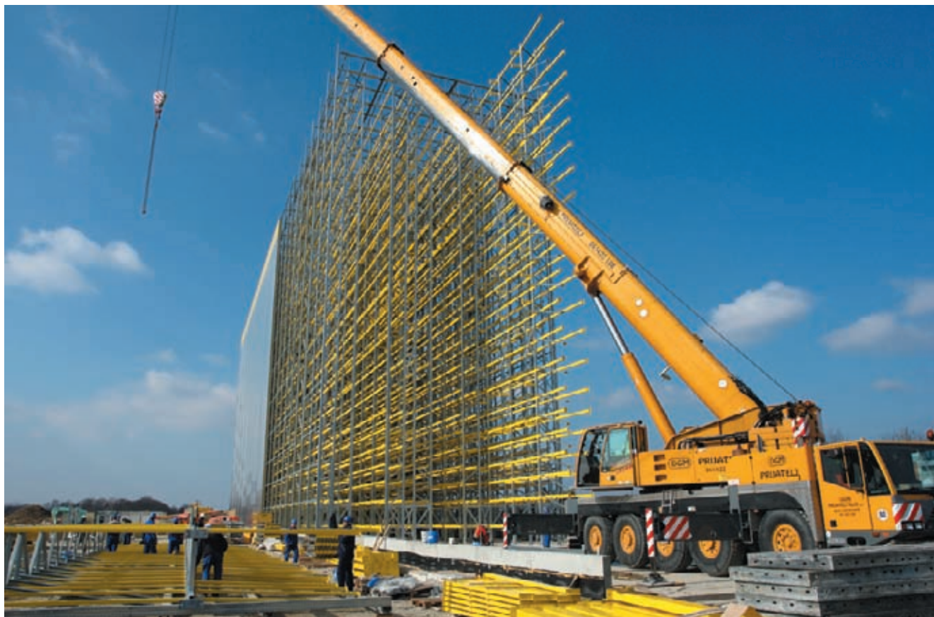
Gradnja visokoregalnega skladišča v Lendavi
