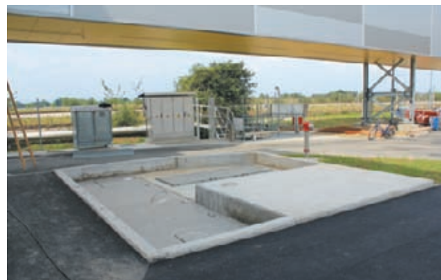
Prečrpalnice odpadne hladilne vode za odvod v reko Muro
