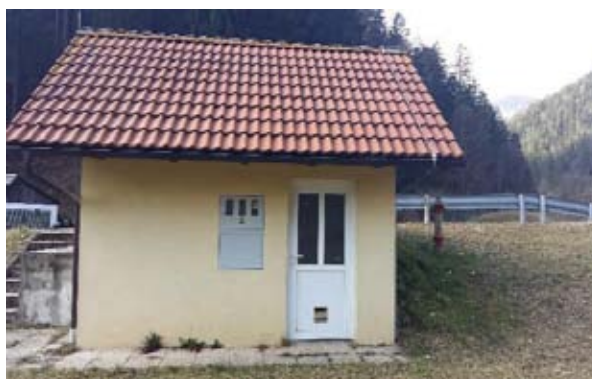
Slika 6: Mala hidroelektrarna v Suhem dolu.
