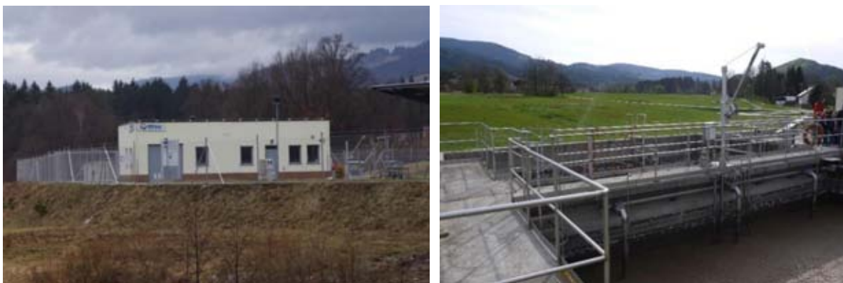
Slika 9: Čistilna naprava Mislinja.
