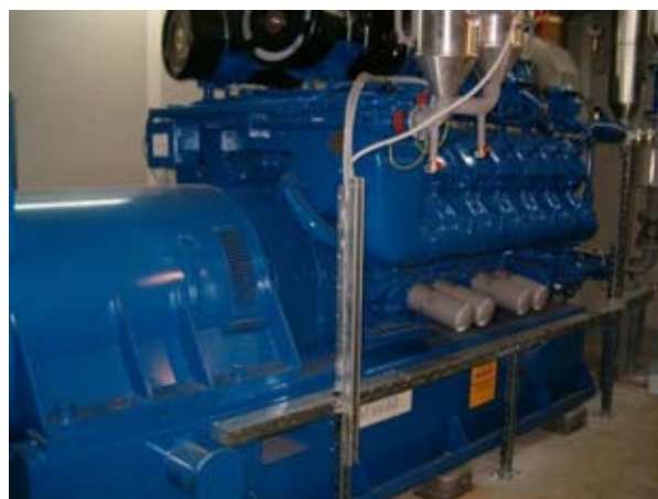
Slika 7: Kogeneracija na toplarni na Štibuhiu.
