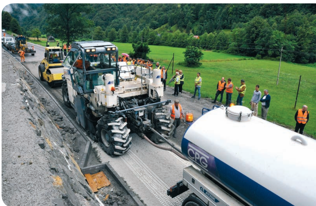
Prikaz postopka hladne reciklaže ceste v okviru projekta ReBirth.
