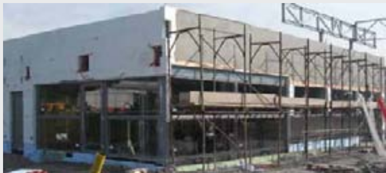
V času gradnje
