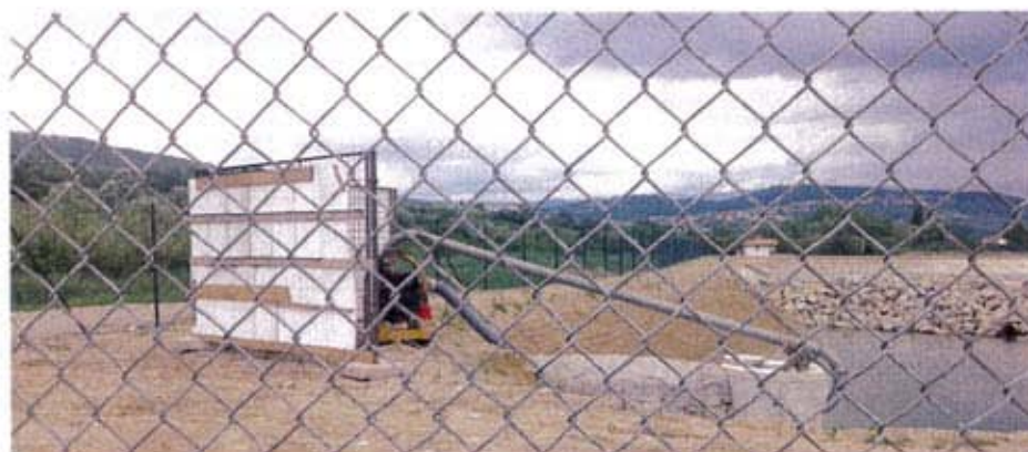
Slika 8. Namestitev protihrupne ograje za preprečevanje širjenje hrupa proti Ankaranu
