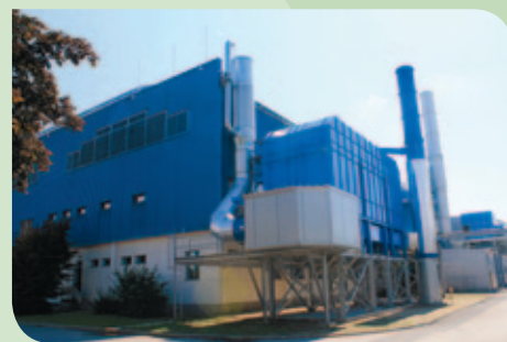
Napravi za regeneracijsko termično oksidacijo hlapnih organskih snovi (RTO) na lokaciji Ljubljana.
