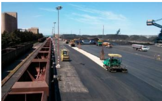
Slika 18. Novo vozilo za čiščenje površin in asfaltiranje deponije premoga
