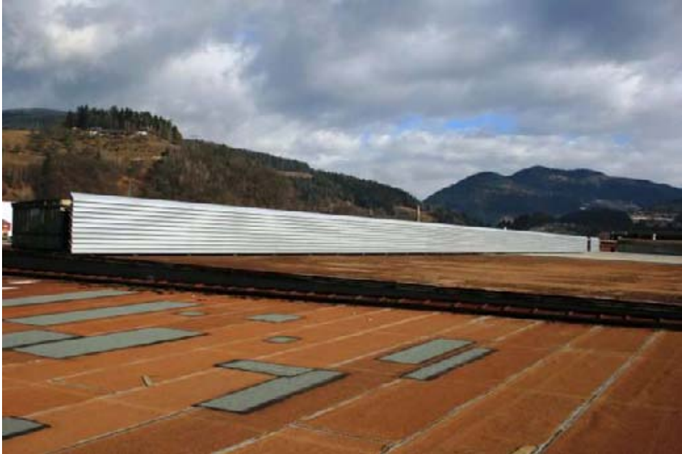
Slika 7: Protihrupna zaščita na strehi Valjarne
