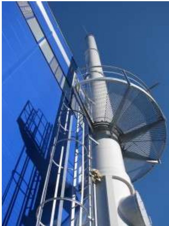
Slika 6 : Odvodnik v novem obratu EPŽ 3
